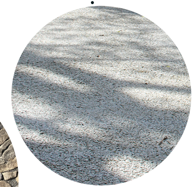
PROMENÁDA - PROBARVENÝ PROPUSTNÝ BETON (šíře 4 m)
