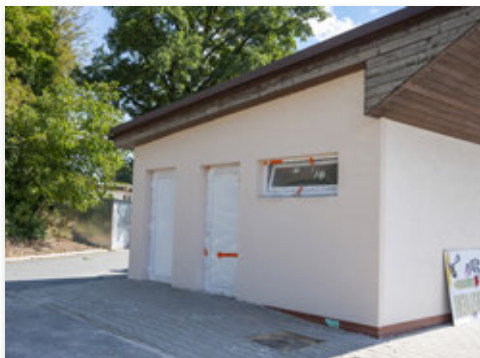
V září byla dokončena rekonstrukce veřejných záchodů u atletického stadionu.
