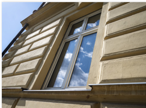
Na budově domova důchodců proběhla finální etapa výměny oken.
