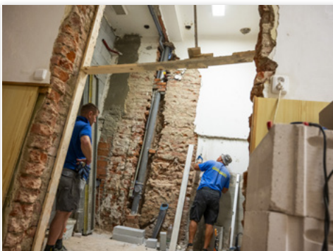
V ZŠ Náměstí dokončují rozsáhlou rekonstrukci sociálního zařízení.
