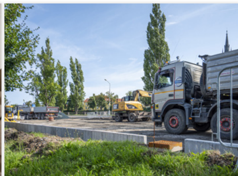
O prázdninách začala stavba nového parkoviště nad skateparkem.
