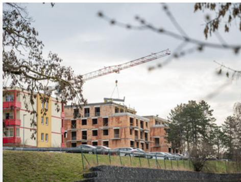
Bytové domy v ulici Prokopa Holého mají hotovou hrubou stavbu.
