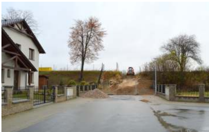
Vzniká nová komunikace k lokalit Cihelna III.
